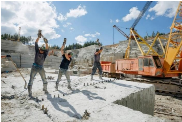
Рисунок 2. Добыча породы буроклиновым способом
